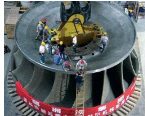
Barrage des Trois gorges Chine
